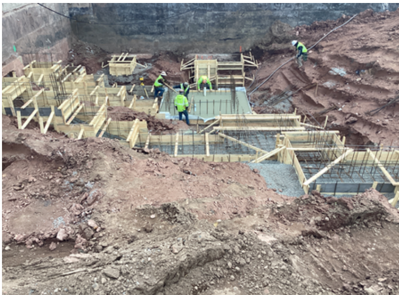
Music Suite Concrete Pour
